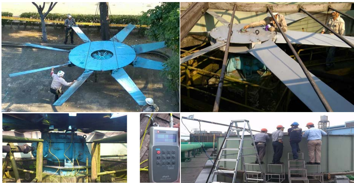
直徑 7.4M 冷卻塔風車扇葉 (2014.11.25)
