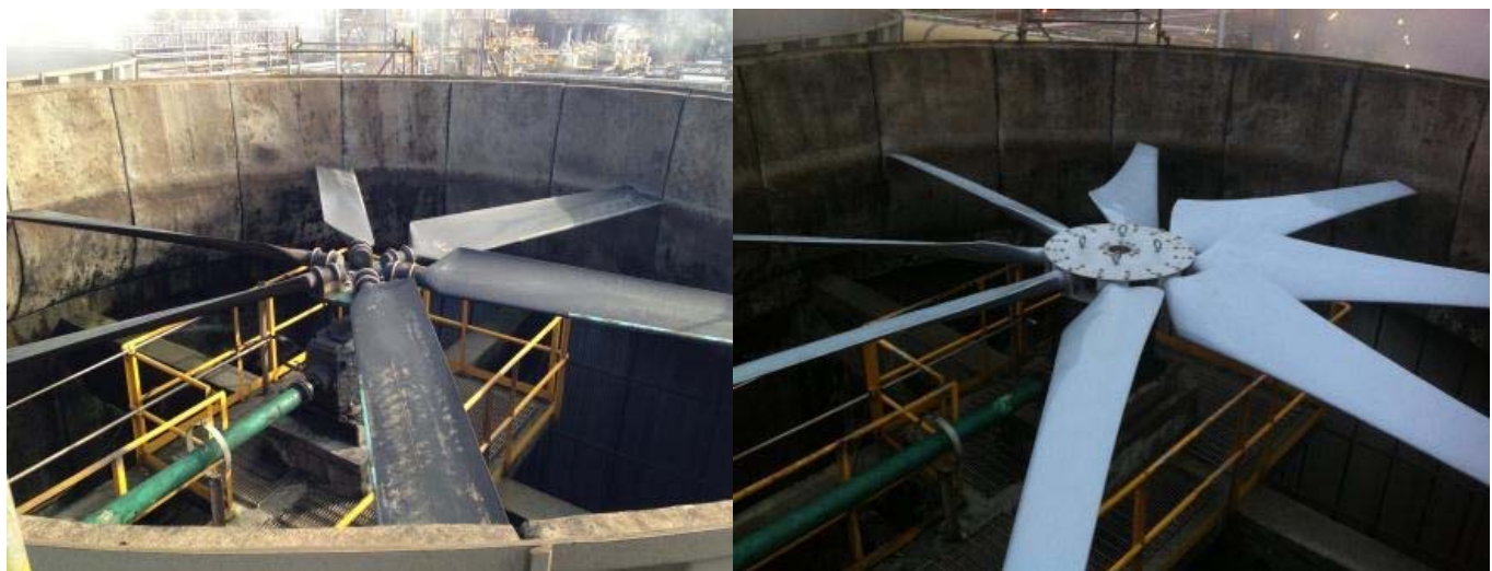
直徑 8.5M 冷卻塔風車扇葉(2014.06.15)
