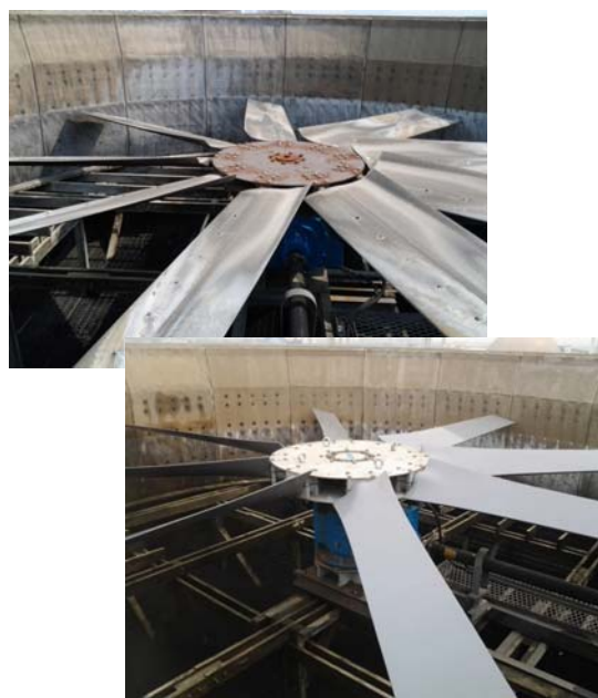
直徑 7.925M 冷卻塔風車扇葉(2014.03.20)
