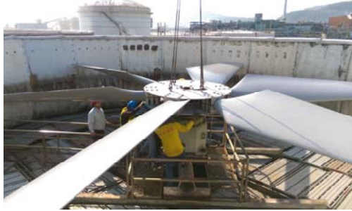
直徑 12.2M 冷卻塔風車扇葉
