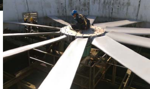
直徑 10M 冷卻塔風車扇葉
